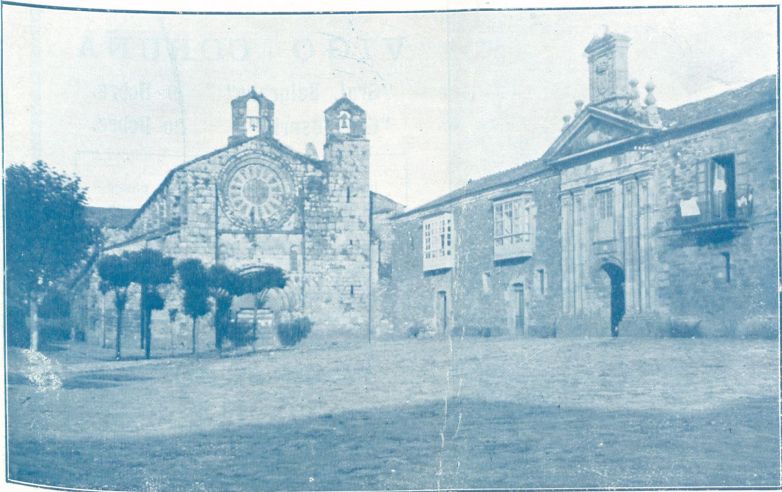
MEIRA (Lugo). — Fachada de la Iglesia y Casa Consistorial.
